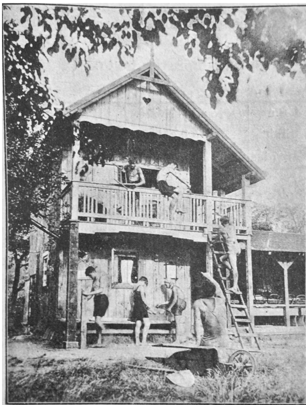
Ilustrace 14: Dokončujeme stavbu farmy.
